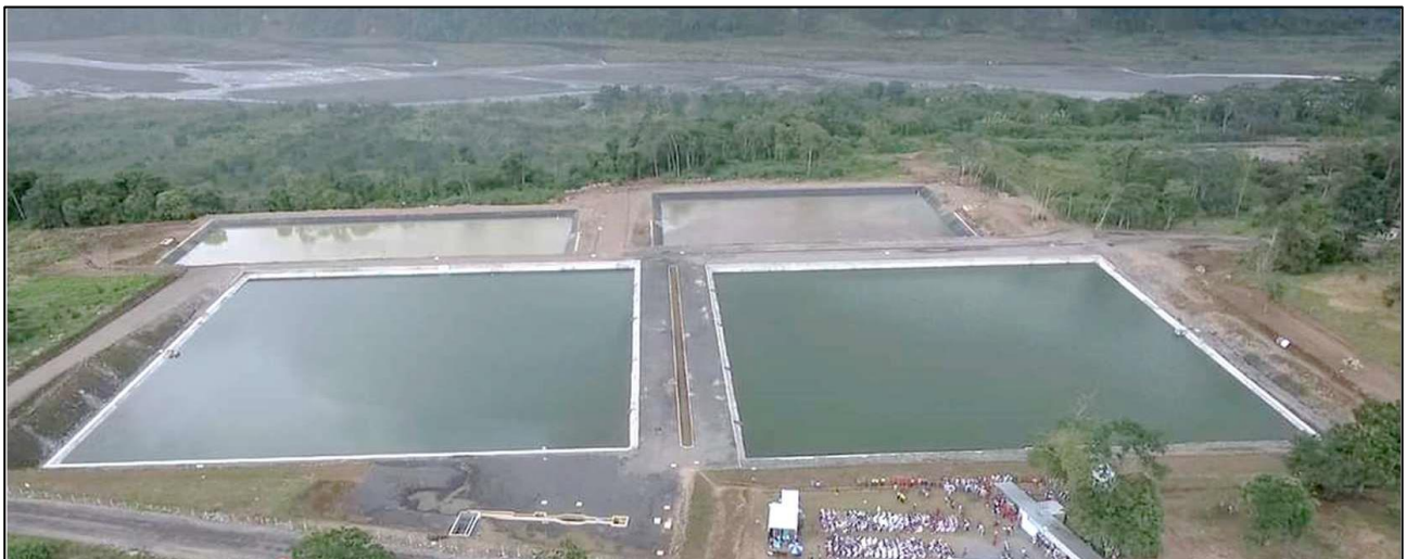
PTAR ciudad de Macas
