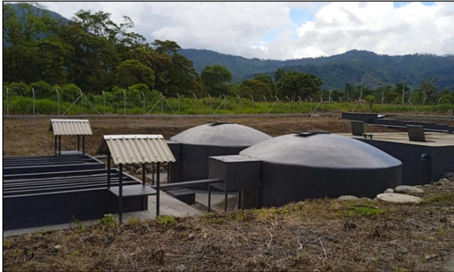
PTAR San Isidro
