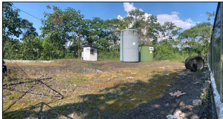
PTAR General Proaño
