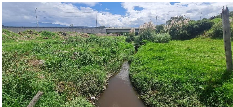
Ilustración 8. Modo de conducción actual de aguas negras y grises
